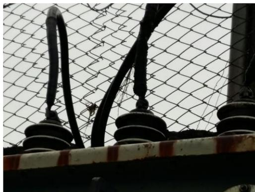
El daño se presentó por corto circuito que afectó los cables y las protecciones que llevan la energía desde la media tensión hasta el transformador. Para reiniciar la operación se hará el mantenimiento correctivo que consiste en el cambio del cableado afectado, las protecciones y las borneras que sujetan dichos cables.
