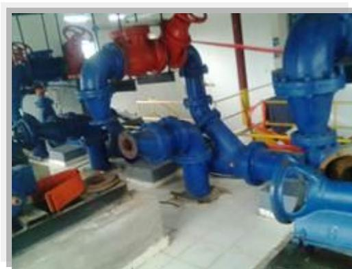
El suministro al sector Centro se ha visto reducido en atención a que se trabaja con una unidad de bombeo en Planta La Loma y Planta Playita, lo anterior debido a desgastes en el eje que afecta los bujes y el rodamiento exterior del resto de las bombas en Planta La Playita y fallas eléctricas en Planta La Loma en el motor. En estos momentos se están realizando las gestiones respectivas para la reparación del resto de las bombas.
