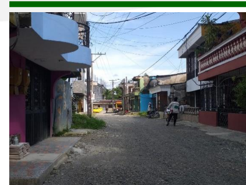
Sensibilización a través de perifoneo y volante a los habitantes del barrio los Rosales, sobre optimización del servicio de acueducto y uso racional y eficiente del agua.
