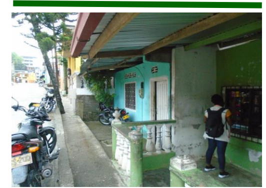
Aplicar encuesta a los habitantes del barrio Playita sector Callejón, para medir la efectividad de los trabajos de mantenimiento y limpieza de desagüe de la planta Playita.
