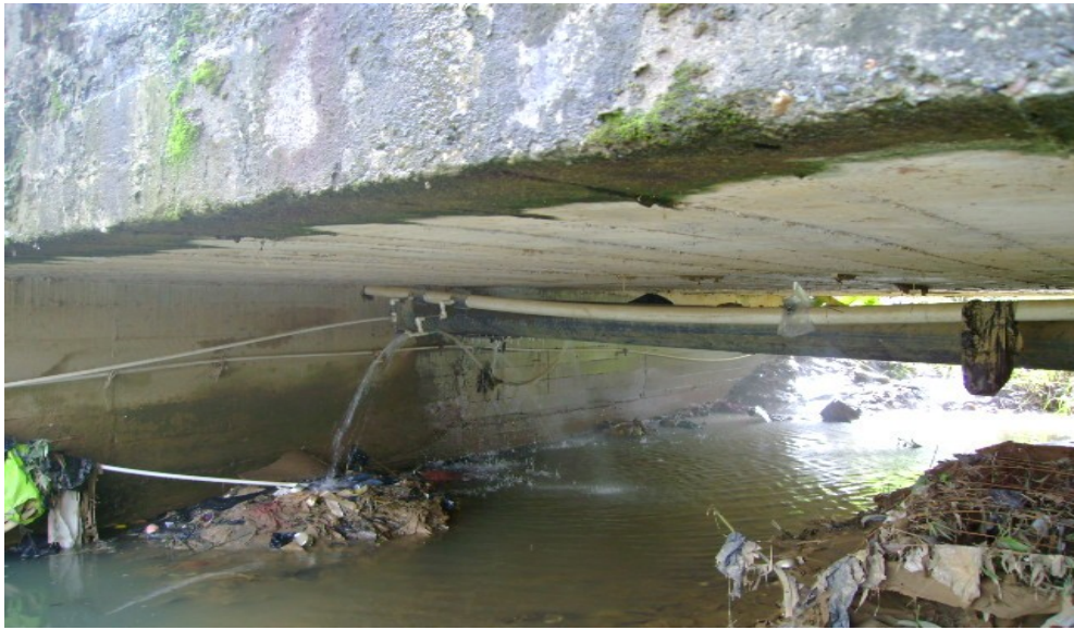
Recolección de basura en la Yesca, Acometidas ilegales dañadas en la Yesca
