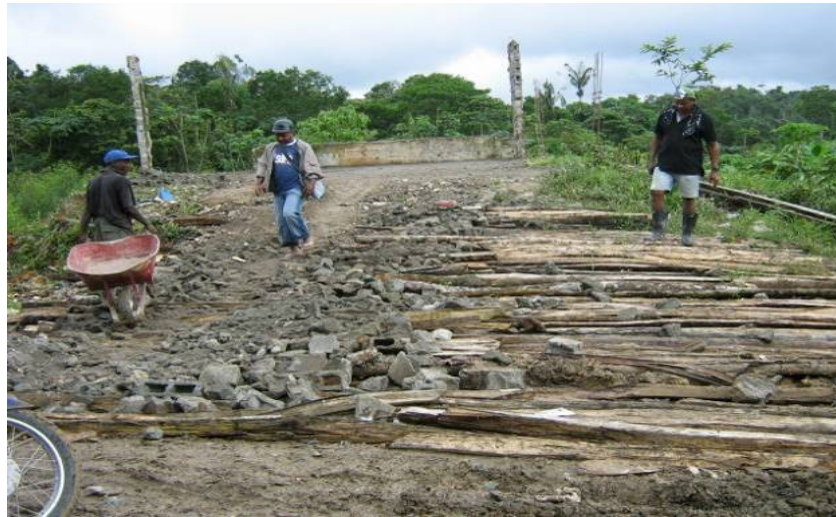
TRABAJOS DE ADECUACIÓN VÍA DE ACCESO
