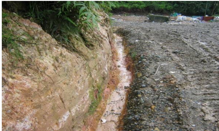
CONFORMACIÓN DE CUNETAS
